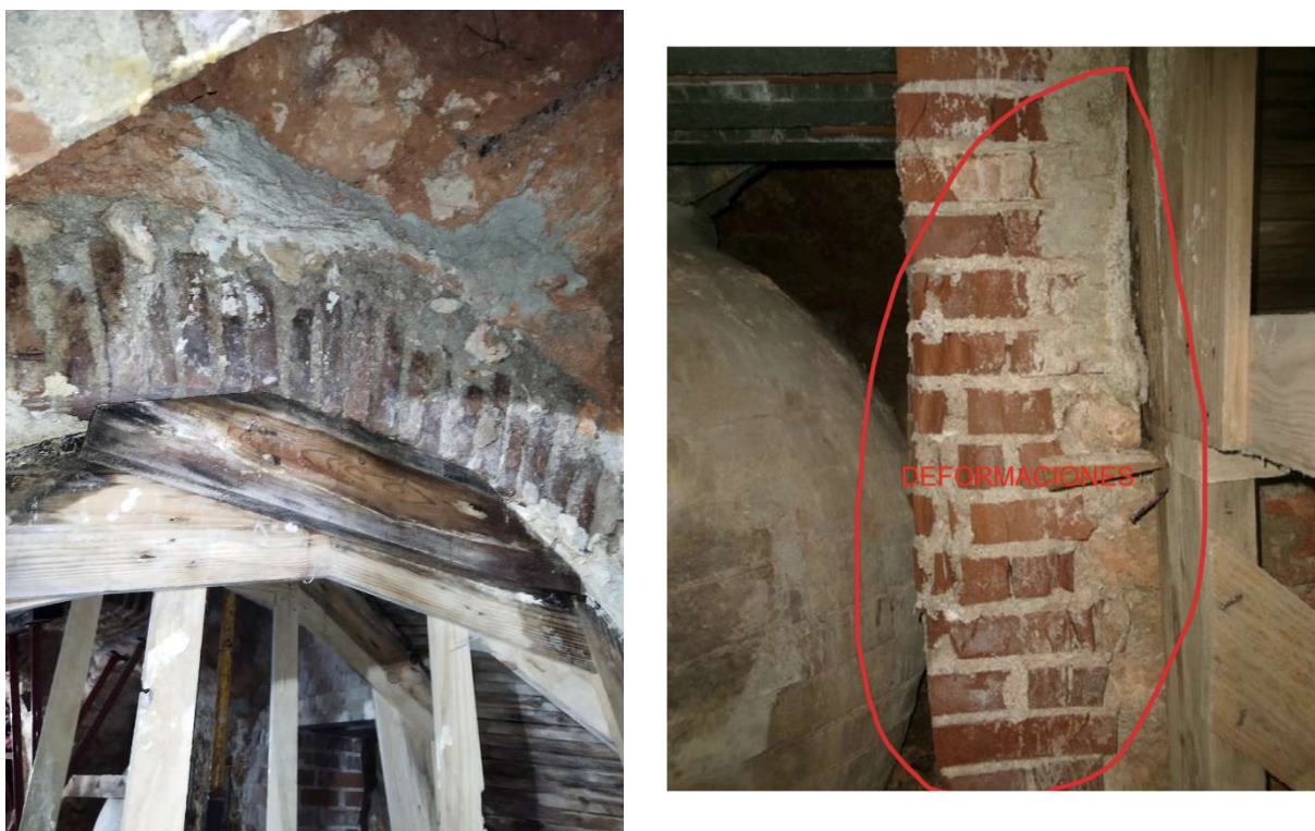
Figura 14: Vistas de la degradación en fábricas
