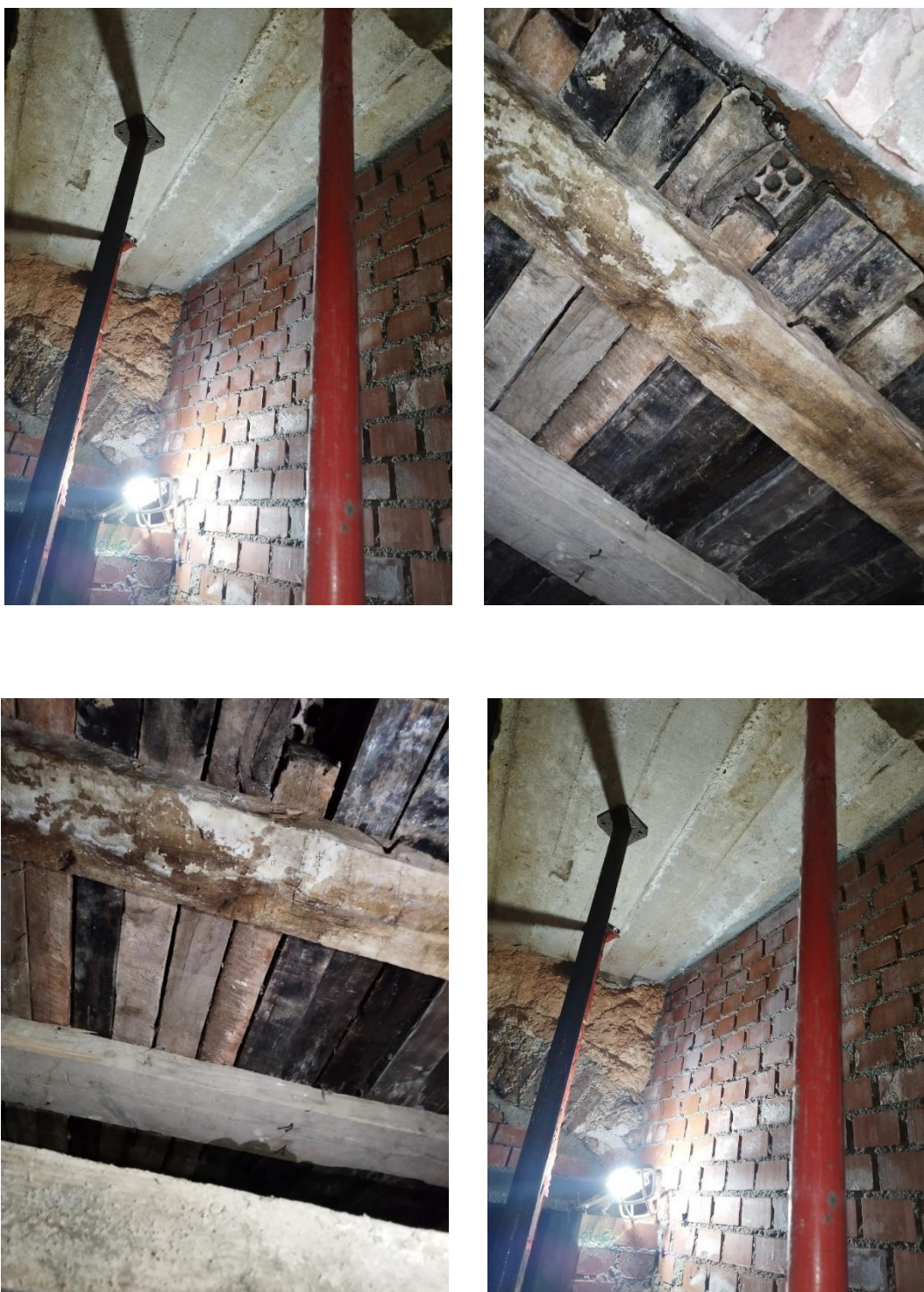
Figura 13: Tramo con elementos dispuestos para el sostenimiento de zonas de características deficientes
