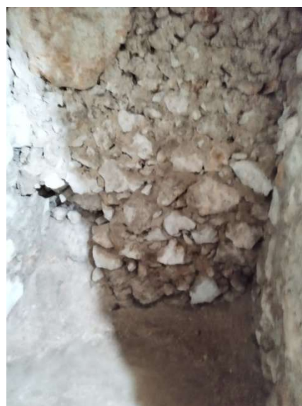
Revestimiento en pared con mampostería
