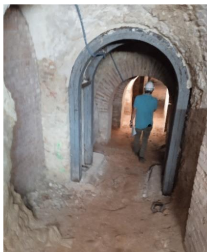
Refuerzo de arco y pilastras entre nichos 20 y 21
