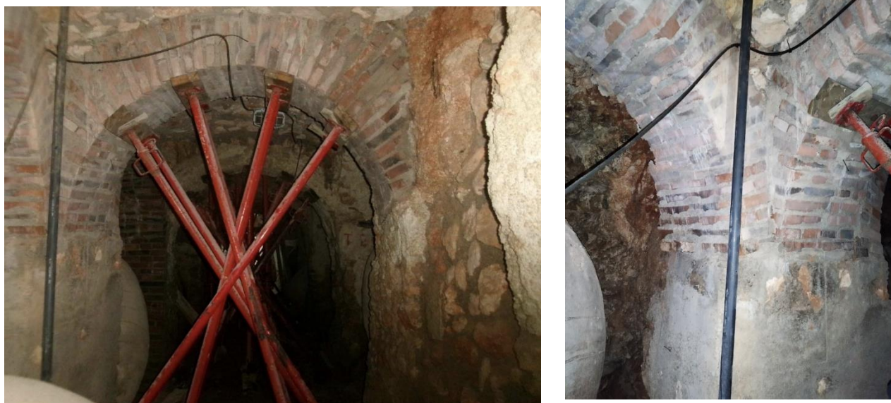
Figura 15: Vistas de reparaciones de la fábrica original con nueva fábrica
