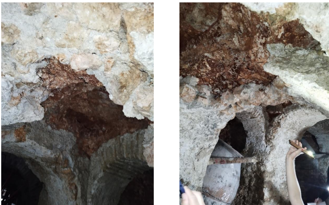
Figura 18: Vistas de daños y deterioro en las fábricas y terreno en las zonas bajo viales no apuntaladas
