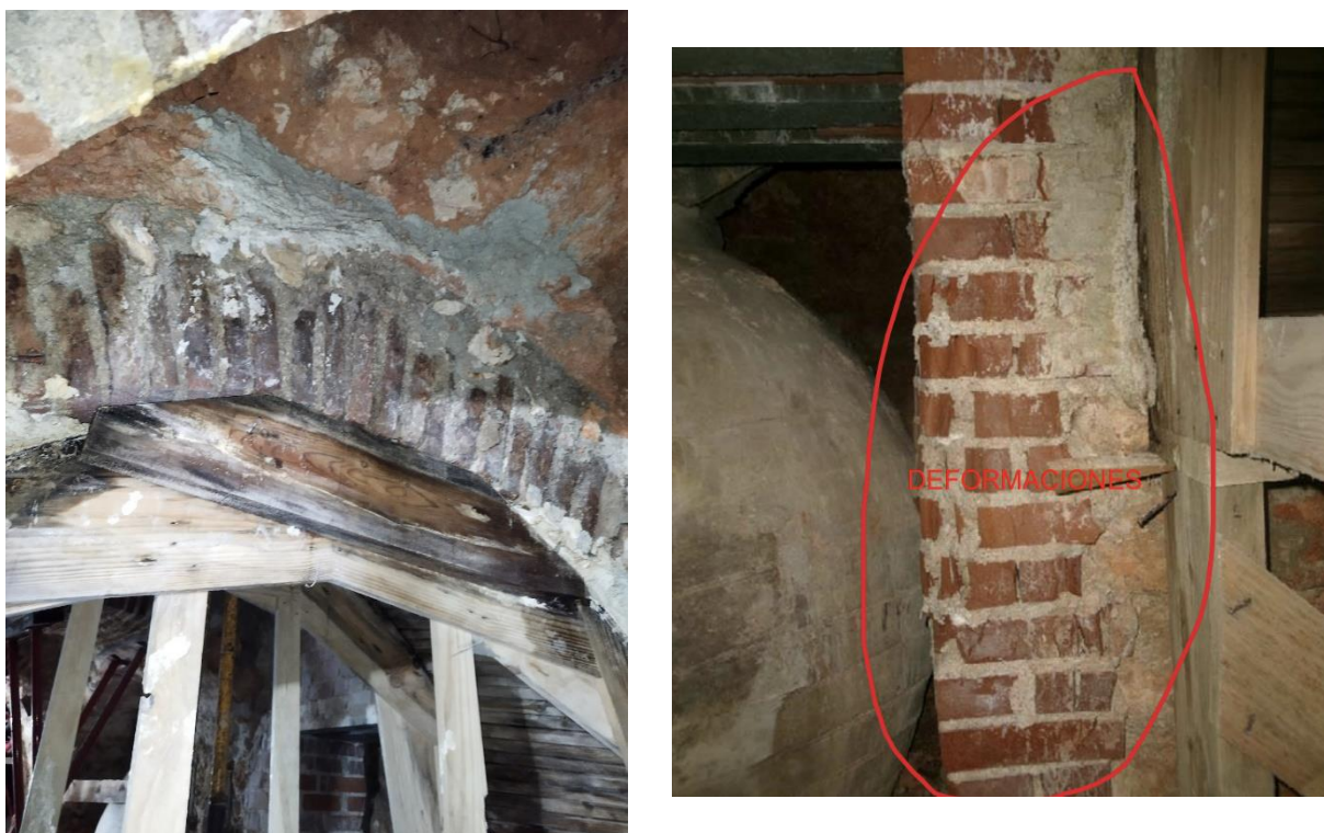
Figura 14: Vistas de la degradación en fábricas
