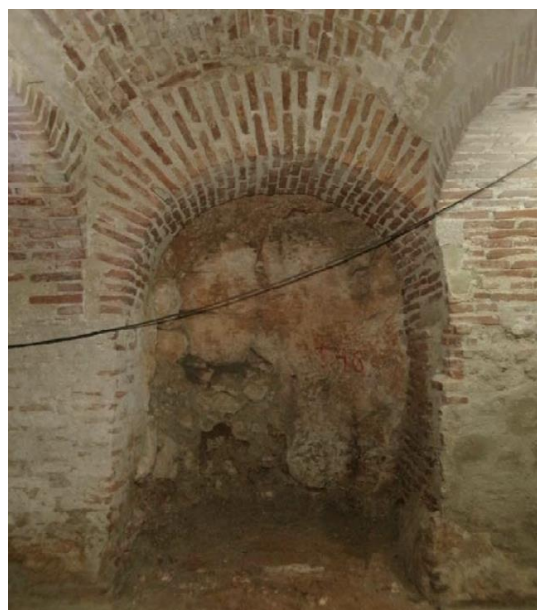
Techo revestido de fábrica de ladrillo
