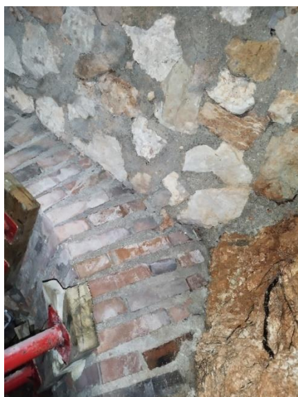
Revestimiento de mampostería en techo
