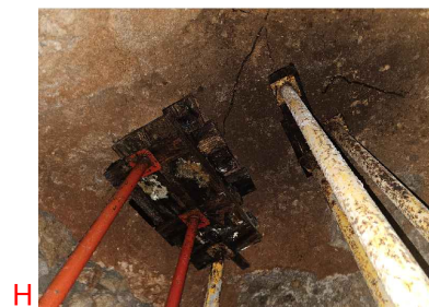
G ESTRUCTURA DE APEO Y CAMÓN DE MADERA
