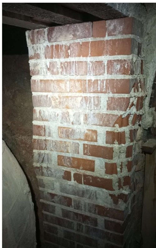
Figura 16: Anomalías en las reparaciones de la fábrica original con nueva fábrica
