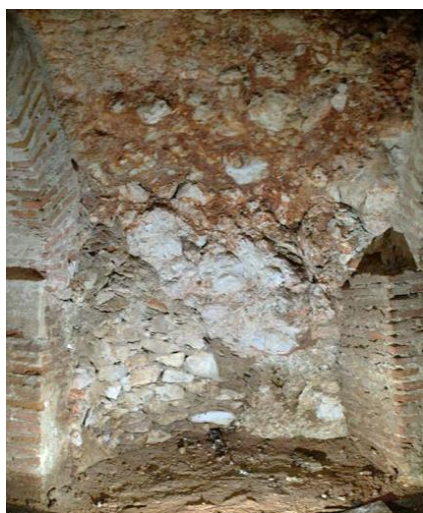
Sustitución de terreno en nichos por mampuestos recibidos con mortero
