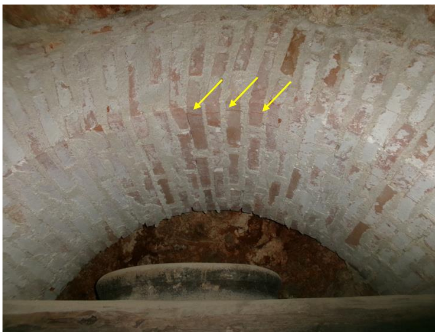
Figura 11: Fisura en clave de arco
