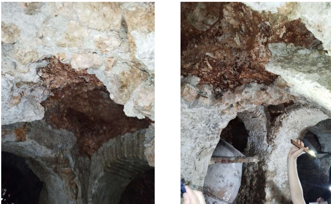
Figura 18: Vistas de daños y deterioro en las fábricas y terreno en las zonas bajo viales no apuntaladas
