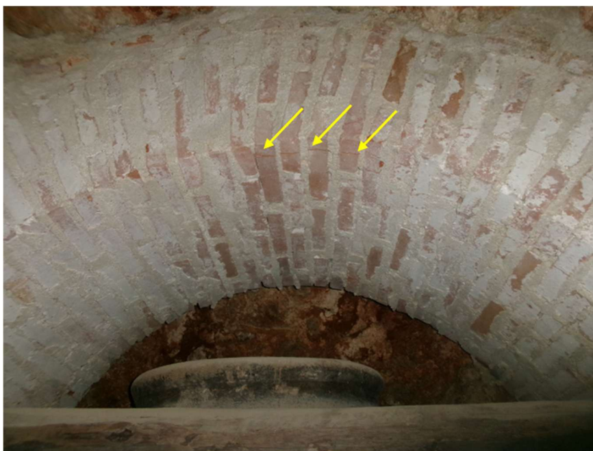
Figura 11: Fisura en clave de arco
