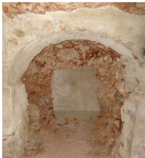
Rejuntado con mortero y en ocasiones mampuestos de arcos y pilastras.
