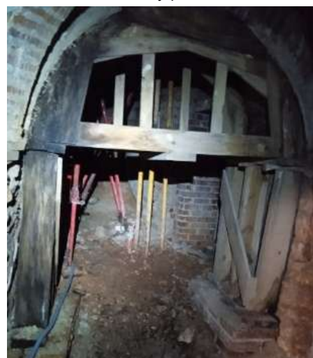
Tramo apeado con puntales y estructura de madera
