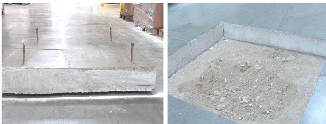
Figura 24. Ejemplo de retirada de solera mediante pernos e izado
